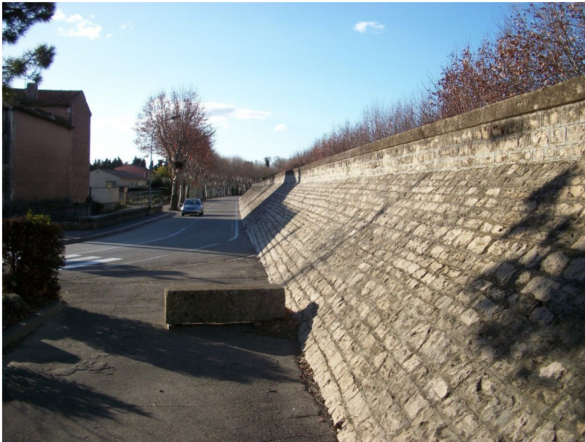
Digue de Caderousse (84) - Photo : GAllegre
