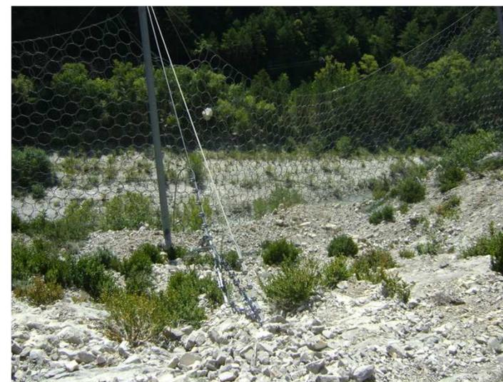
Remplissage → Diminution hauteur utile
