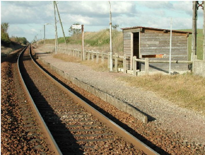
Halte de Wacquemoulin avant travaux (2002)
