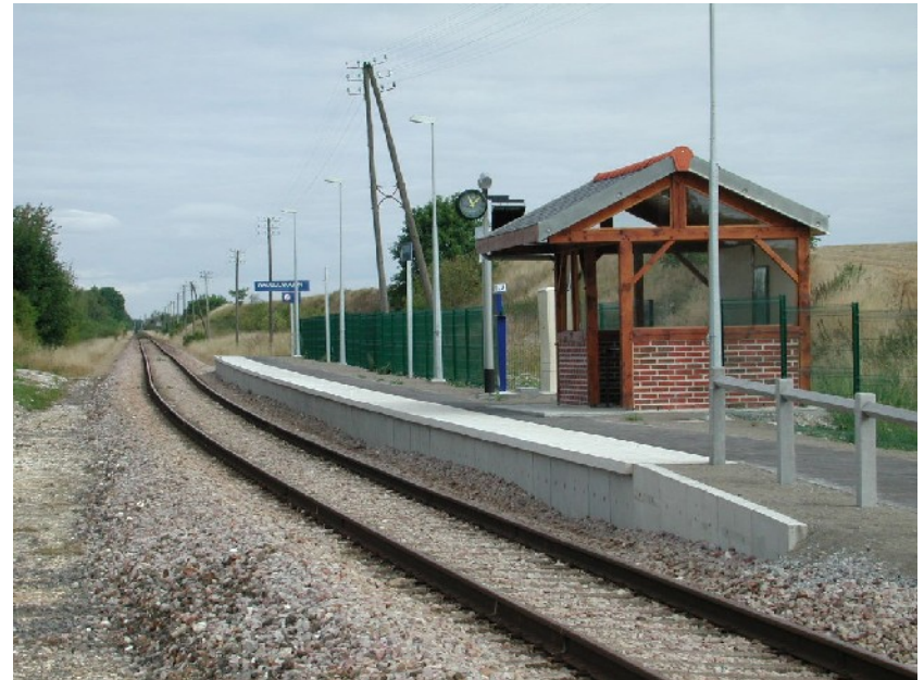
Halte de Wacquemoulin après travaux (2003)
