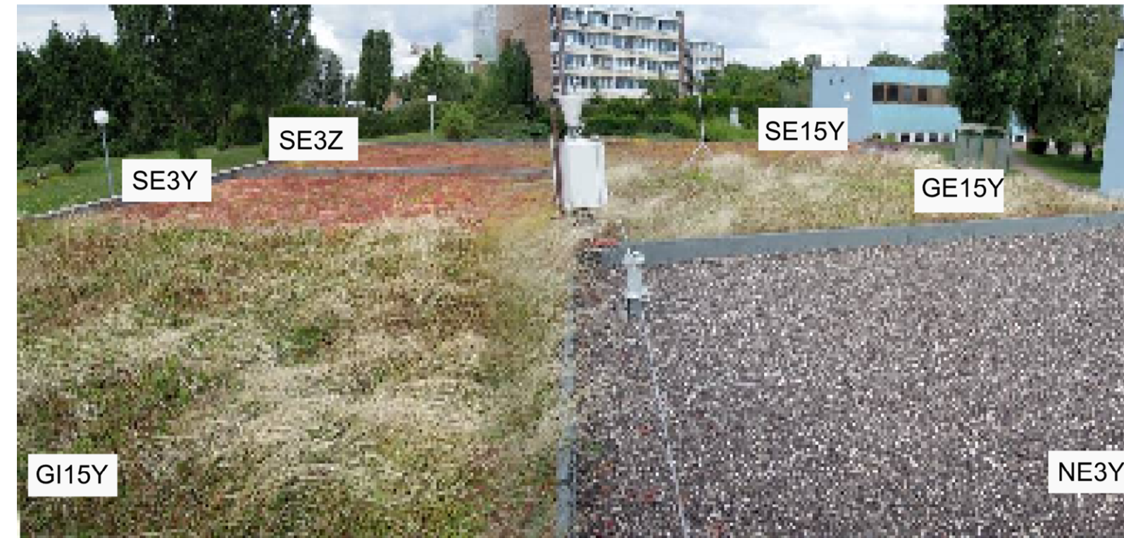
Figure 3 : Photographie des compartiments végétalisés de Trappes
