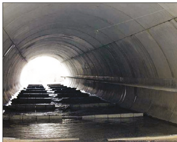
Photo n°9 : Barrettes dans un ouvrage hydraulique aménagé avec un encorbellement. (© Freyssinet).
