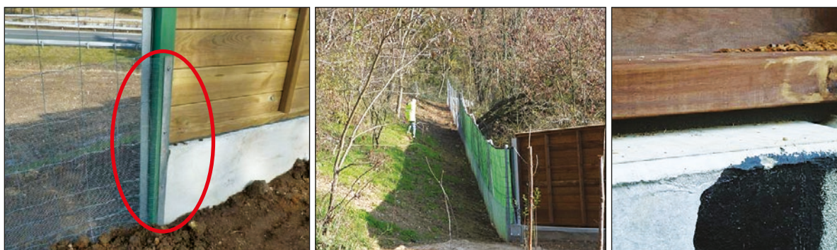
Photos n°36 : Raccord correct, brise vue avec jambes de force et joint souple sous écran (de gauche à droite). (© VINCI Autoroutes)
