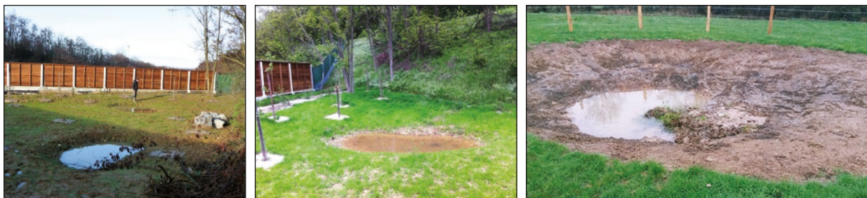
Photos n°37 : Réalisation de mares. (© VINCI Autoroutes).
