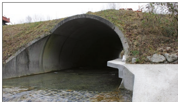
Photo n°8 : Raccord de berge d'un encorbellement d'ouvrage hydraulique. (© Freyssinet).
