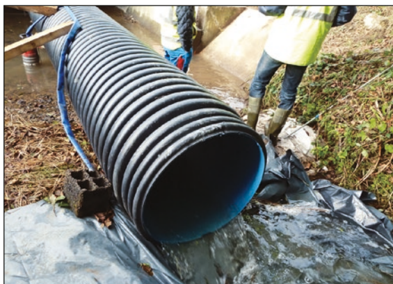
Photo n°48 : Bâchage anti-érosif en sortie de la buse de dérivation. (© VINCI Autoroutes).
