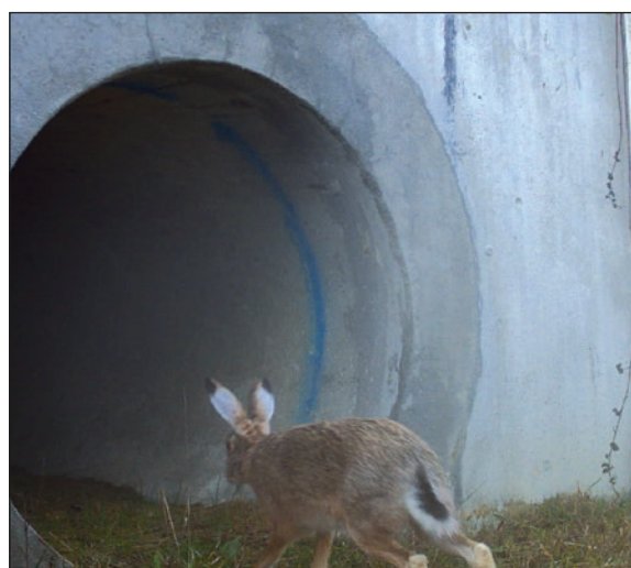
Photo n°11 : Lièvre d'Europe entrant dans un écoduc de 120 cm de diamètre. (© VINCI Autoroutes).
