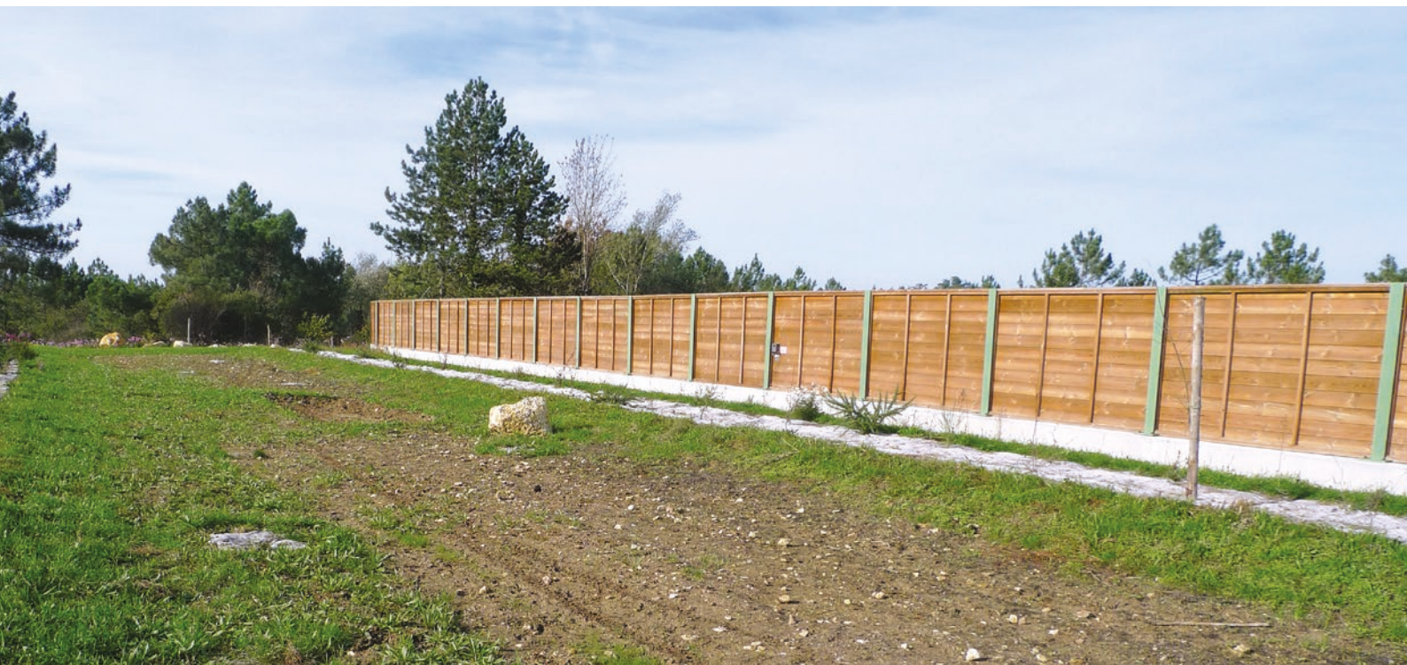
Photo n°25 : Panneaux occultant sur écopont. (© VINCI Autoroutes)
