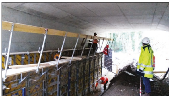
Photos n°44 : Coffrage d'une banquette double marche (gauche) et vue de la banquette achevée à l'intérieur de l'Ouvrage Hydraulique (OH) (droite). (© VINCI Autoroutes).
