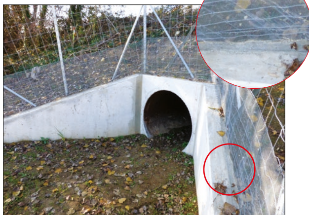
Photos n°30 : Repositionnement semi enterré du grillage renforcé (photo de gauche), jointure au mortier du grillage autour de la tête (photo de droite). (© VINCI Autoroutes).
