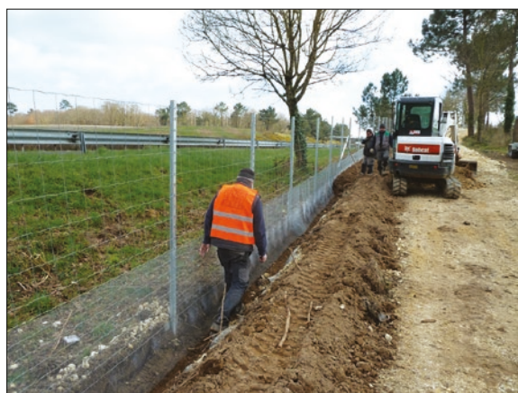
Photos n°30 : Repositionnement semi enterré du grillage renforcé (photo de gauche), jointure au mortier du grillage autour de la tête (photo de droite). (© VINCI Autoroutes).
