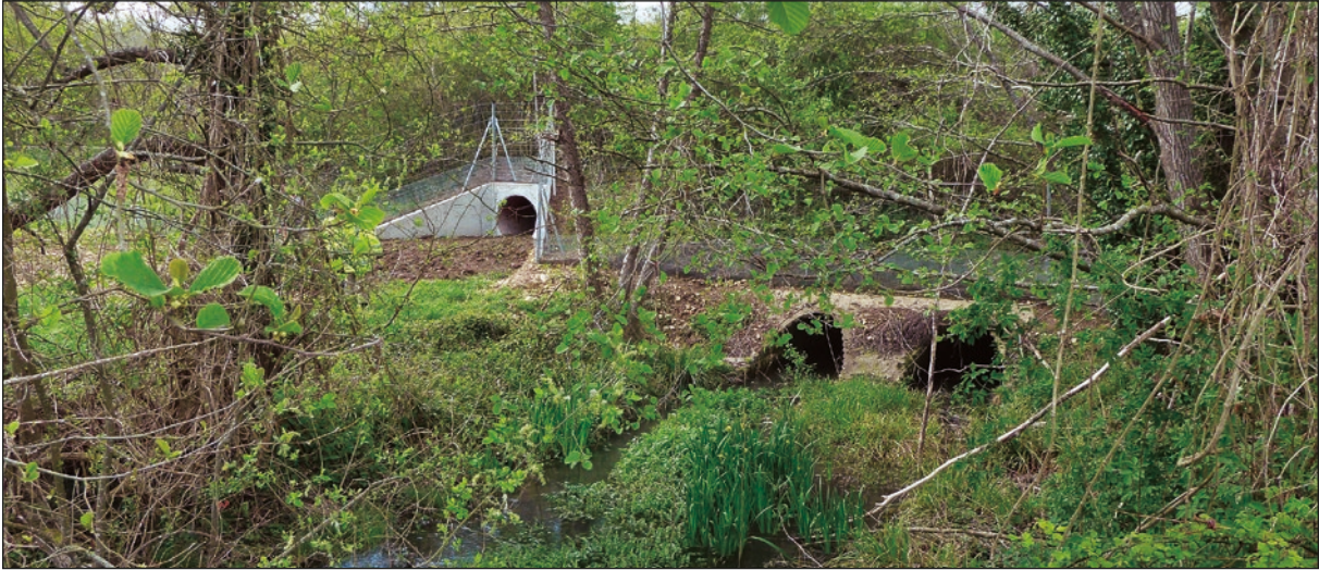
Photo n°7 : Aménagement d'un écoduc (buse sèche avec revêtement terreux) aux abords d'un ouvrage hydraulique. (© VINCI Autoroutes).
