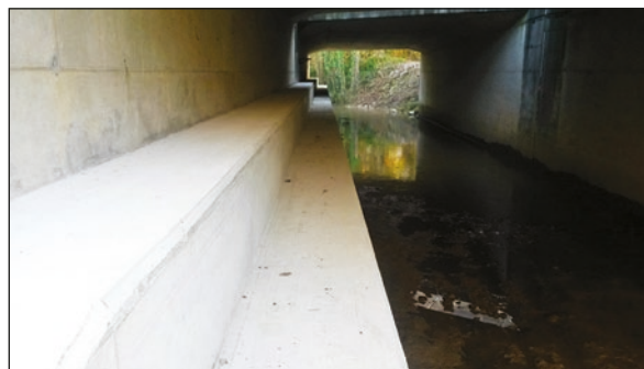
Photos n°44 : Coffrage d'une banquette double marche (gauche) et vue de la banquette achevée à l'intérieur de l'Ouvrage Hydraulique (OH) (droite). (© VINCI Autoroutes).
