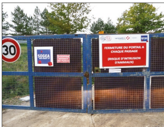
Photo n°41 : Dispositif de portail de chantier avec panneau indiquant la fermeture obligatoire. (© VINCI Autoroutes).
