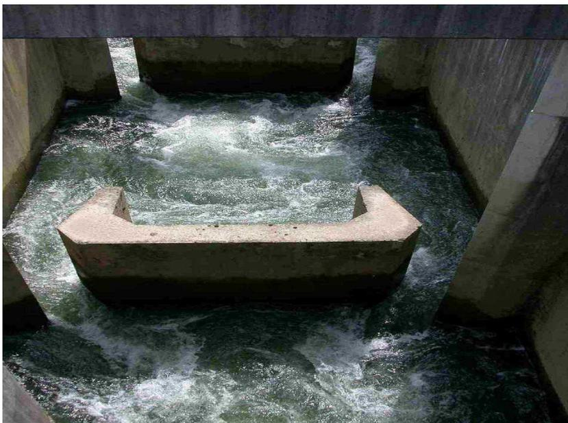
Le principe de ces ouvrages consiste à diviser le dénivelé total de l'obstacle en une **série de bassins** séparés par des cloisons formant un escalier hydraulique .
