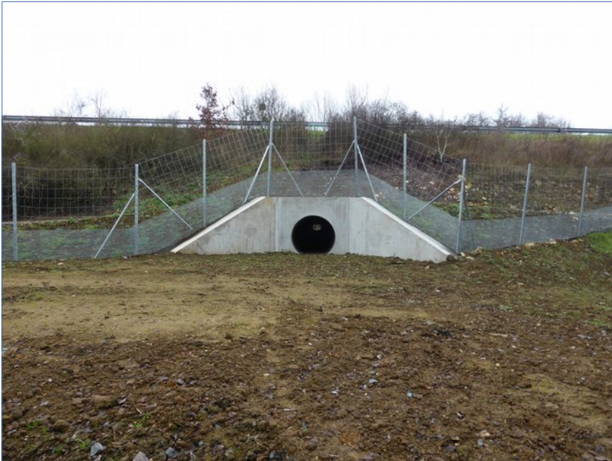
Réalisation d'un fonçage petite faune Autoroute A11/ASF – Source Cerema Ouest
