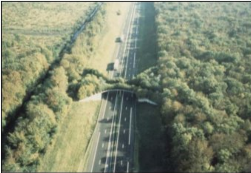
Photo 26 : Autoroute A36 (Haut Rhin), passage en diablo Source : J. Carsignol – Cete de l'Est
