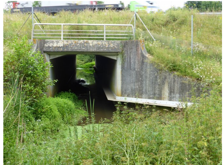
Réalisation d'une banquette en encorbellement A83/ASF – Source Cerema Ouest
