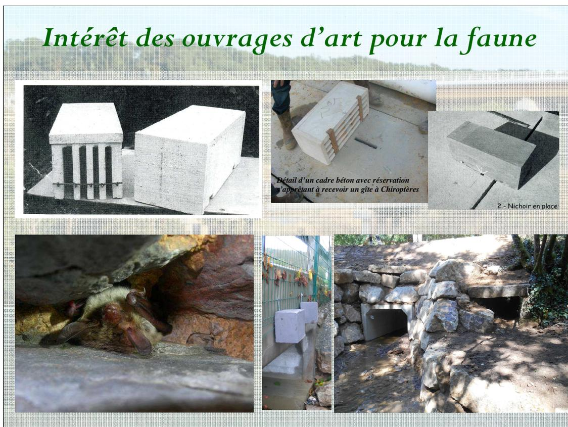
Il est possible d'intégrer des gîtes dans les nouveaux ouvrages (cf communication CD44&GMB). L'intégration dans la structure de l'ouvrage est bien plus intéressante (inertie thermique) que la pose de nichoirs « extérieurs » qui peut même s'avérer dangereuse (mortalité lors de chutes de température)
