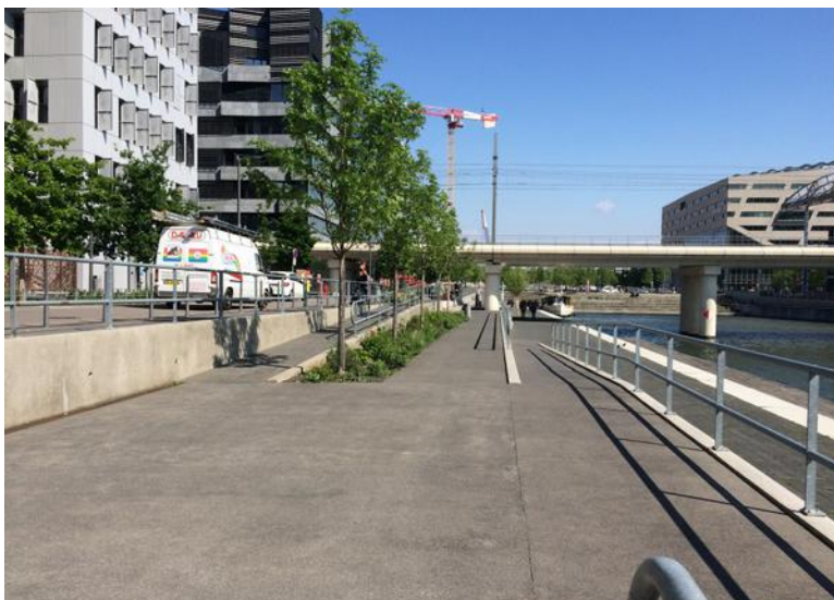
Rampes d'accès aux gradins place nautique
