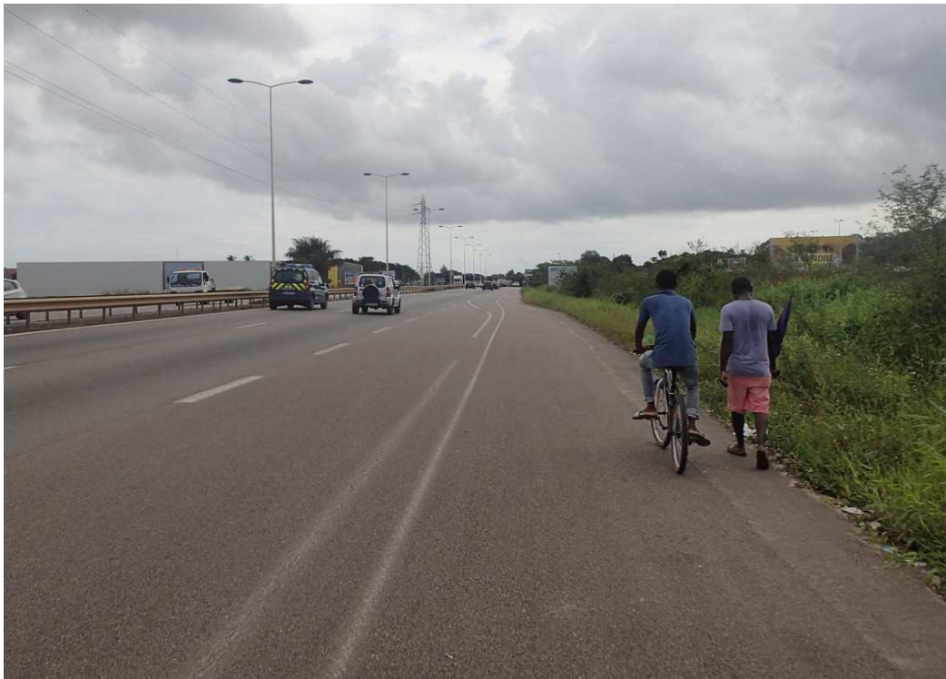
Photo 14: RN1 (hors section) entre le Giratoire de la Crique Fouillée et le Giratoire des Maringouins - La berme cyclable est accessible aux piétons dans des conditions de sécurité relatives sur une section à 2 x 2 voies limitées à 90 km/h. Cet aménagement est également utilisé par les deux roues motorisées.
