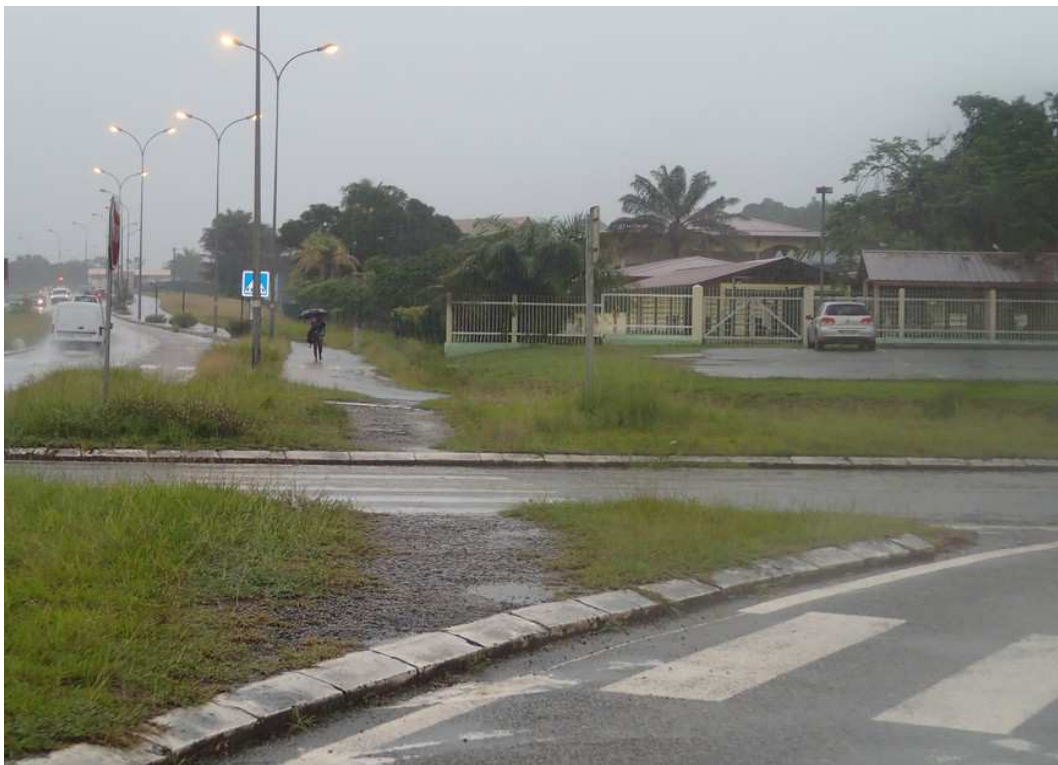
Photo 11: D18 - Rocade du Lycée (Section 10) - La piste cyclable est inaccessible depuis la rocade.
