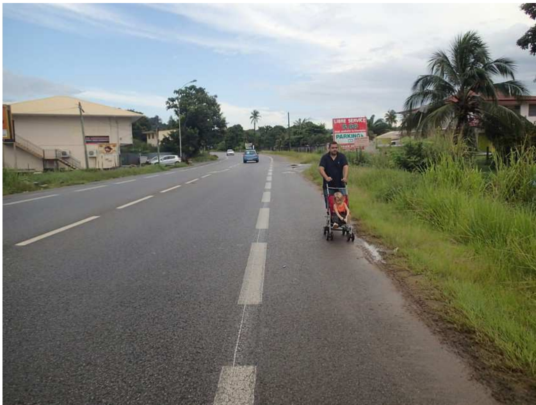
Photo 10: D1-Route de Montabo (section 12) - L'accotement sert aussi de trottoir
