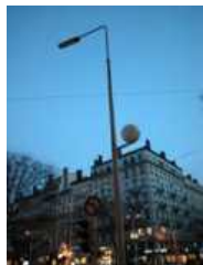
Luminaires avec SBP / Boule Diffusante
