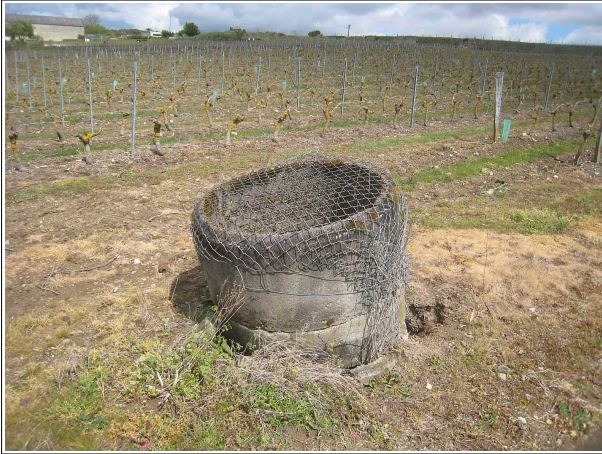
Illustration 2.16 : Puits d'aération d'une carrière souterraine, ouvert et protégé, Saint-Cyr-en-Bourg (49), 2012
