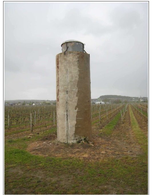
Illustration 2.17 : Appareillage édifié autour d'un puits d'aération, Saint-Cyr-en-Bourg (49), 2012
