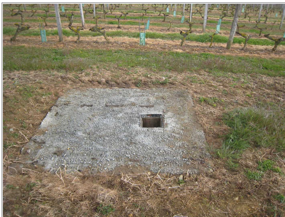
Fermeture d'un puits d'aération d'une ancienne carrière souterraine, Saint-Cyr-en-Bourg (49), 2012
