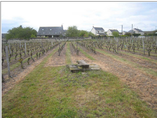
Illustration 2.18 : Fermeture de surface d'un puits d'aération, Saint-Cyr-en-Bourg (49), 2012
