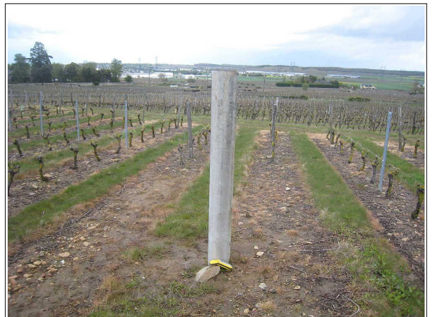
Illustration 2.19 : Puits d'aération comblé, aération maintenue par mise en place d'un tuyau béton, Saint-Cyr-en-Bourg (49), 2012
