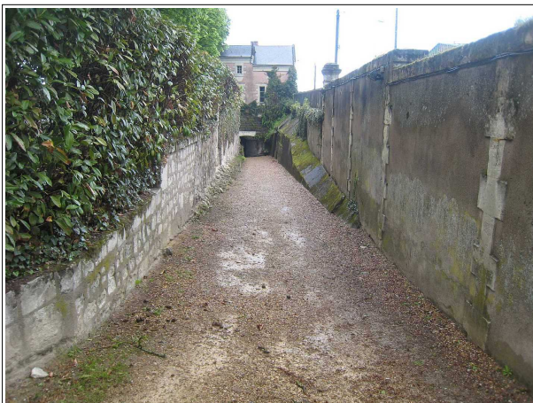
Illustration 2.10 : Descenderie permettant l'accès à une carrière souterraine, Saint-Cyr-en-Bourg (49), 2013
