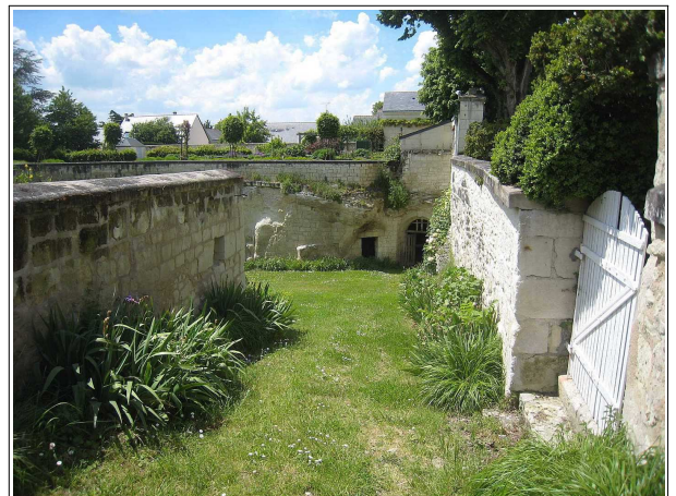
Illustration 2.11 : Carrie permettant l'accès à plusieurs caves et dépendances souterraines, Saint-Cyr-en-Bourg (49), 2013
