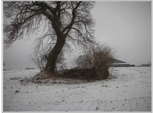
Illustration 2.38 : Effondrement au pied d'un arbre isolé, puits de marnière probable repéré en 2009, situé à l'emplacement de l'objet de l'illustration 2.37
