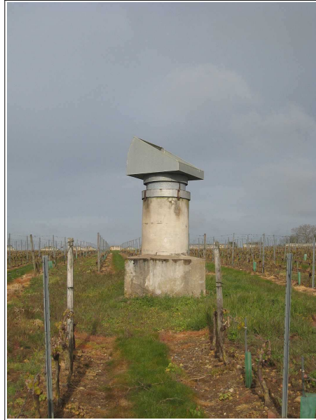
Illustration 2.27 : Puits d'aération d'une carrière visible en 2012, correspondant à l'un des objets de l'illustration 2.24
