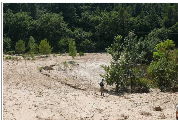
Illustration 1.15 : Effondrement généralisé d'une cavité naturelle gypseuse, La Clappe (83) [Cerema DTer Méditerranée, 2010]
