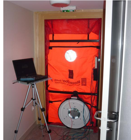
Mesure d'étanchéité à l'air
