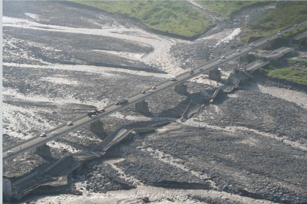
ruine de l'ouvrage aval sur la Rivière Saint-Etienne
