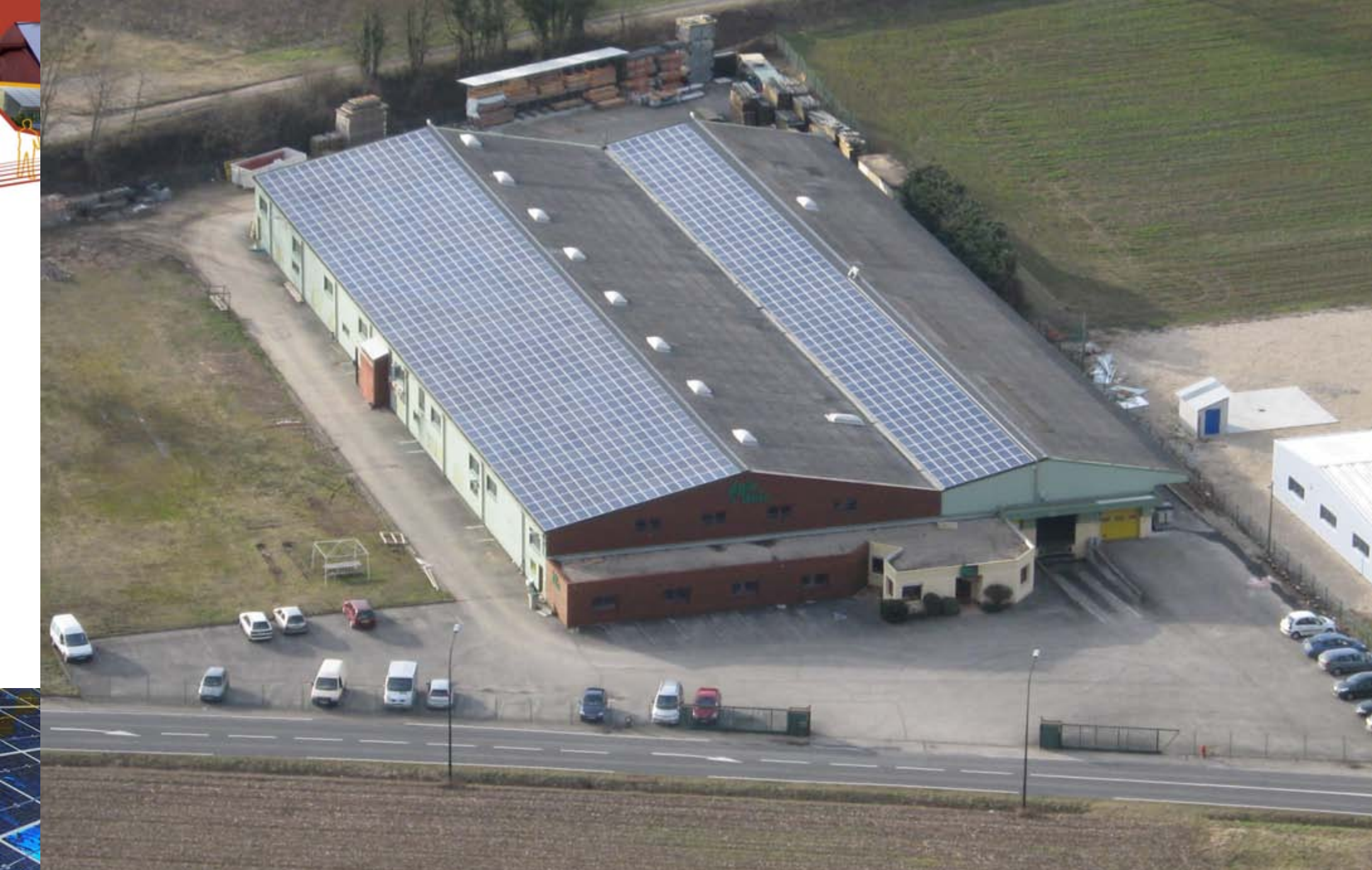
Installation de 1700 m 2 , 228 kW, Usine Pic Bois à Bregnier Cordon (Ain)
