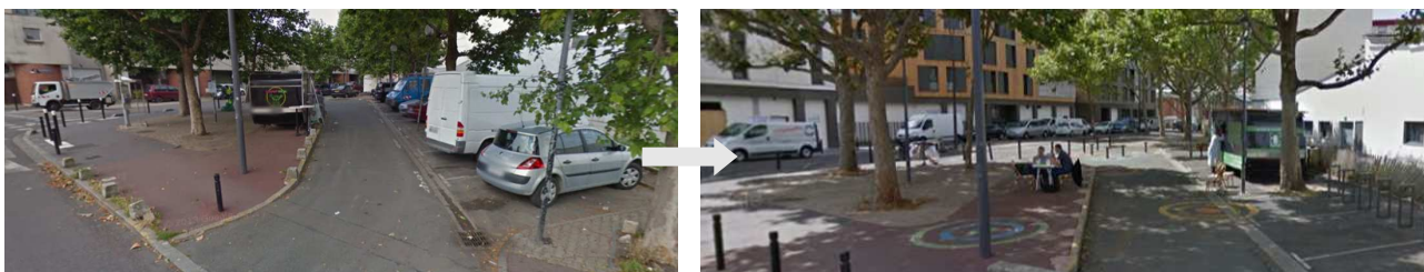
Illustration 3 : rue de Valmy avant et après - Montreuil (source : Google)
