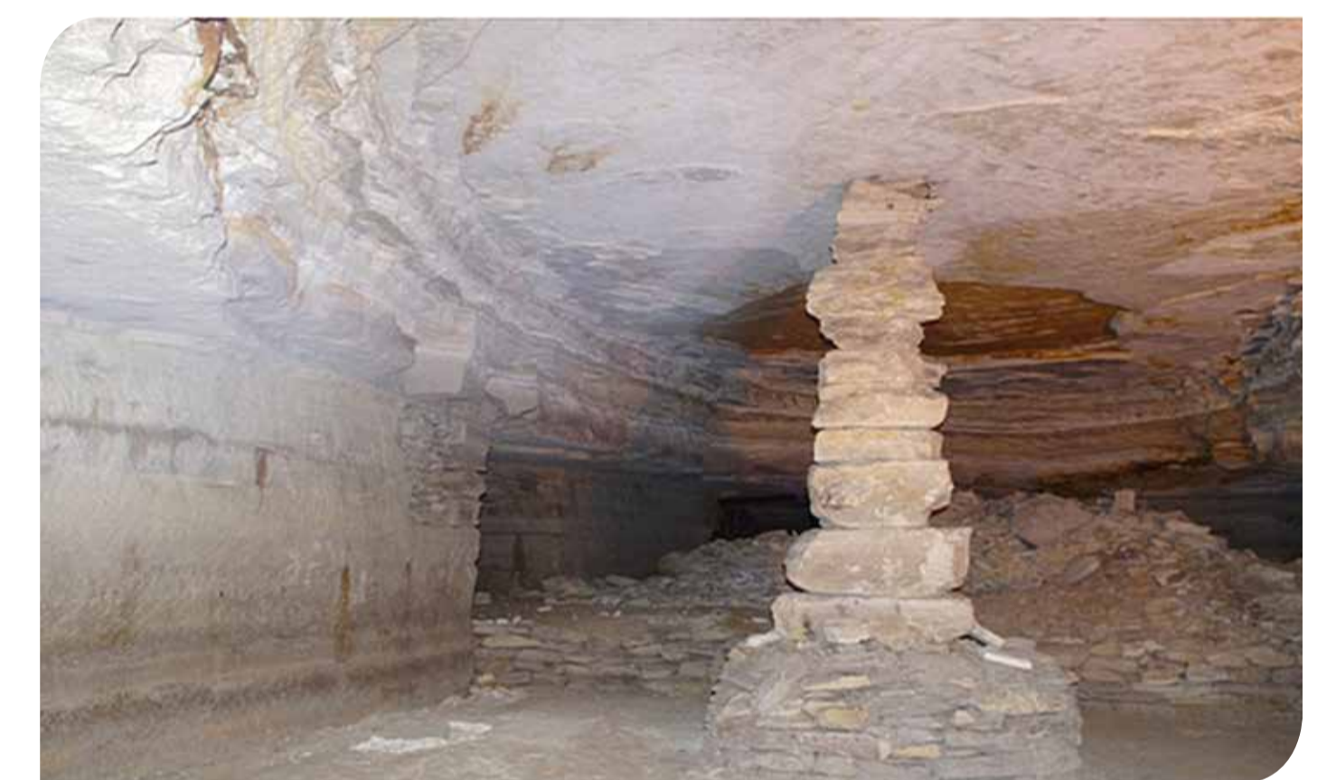
Début d'amorçage d'un fontis (Carrière de la Brasserie, Paris 12 ème arrondissement) © INERIS
