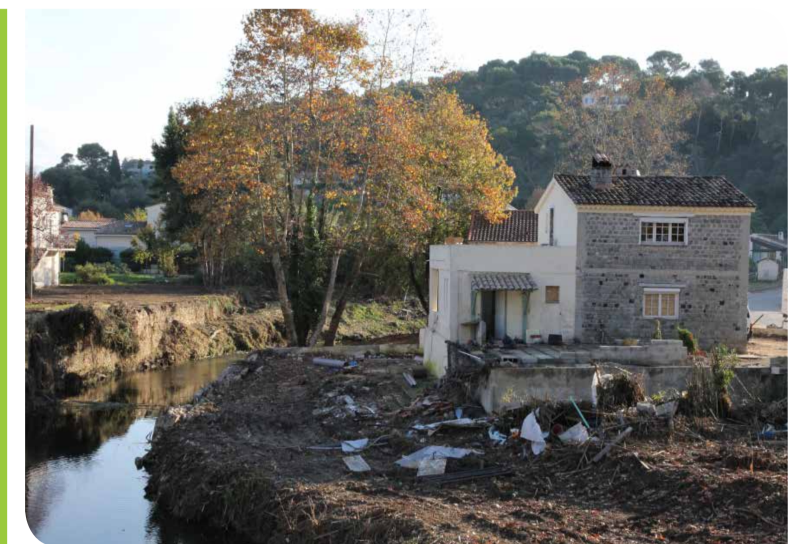
Maison endommagée en bordure de la Brague, lors des intempéries du 3 octobre 2015 (© Cerema)
