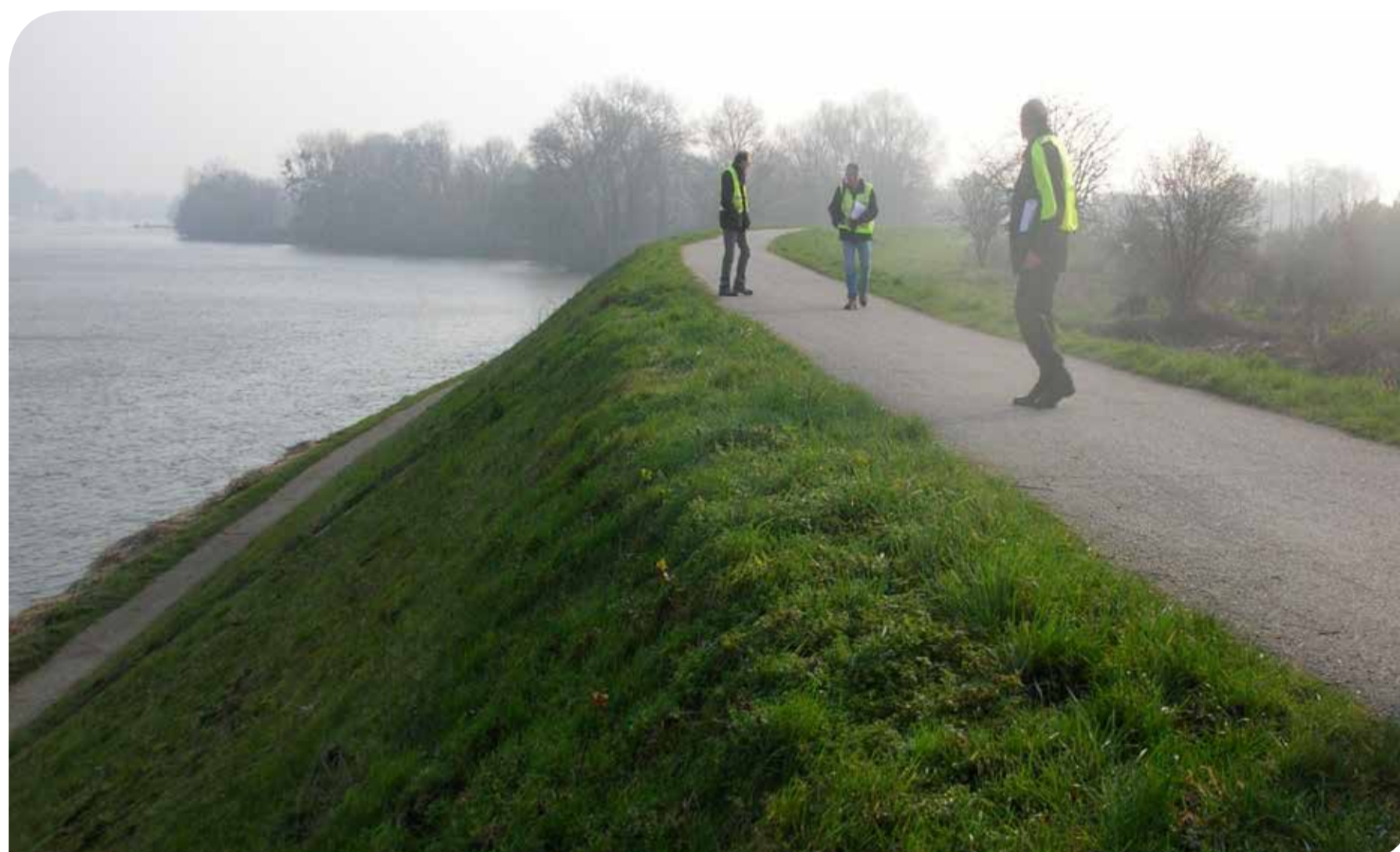
Inspection des digues de la Loire (© Irstea)
