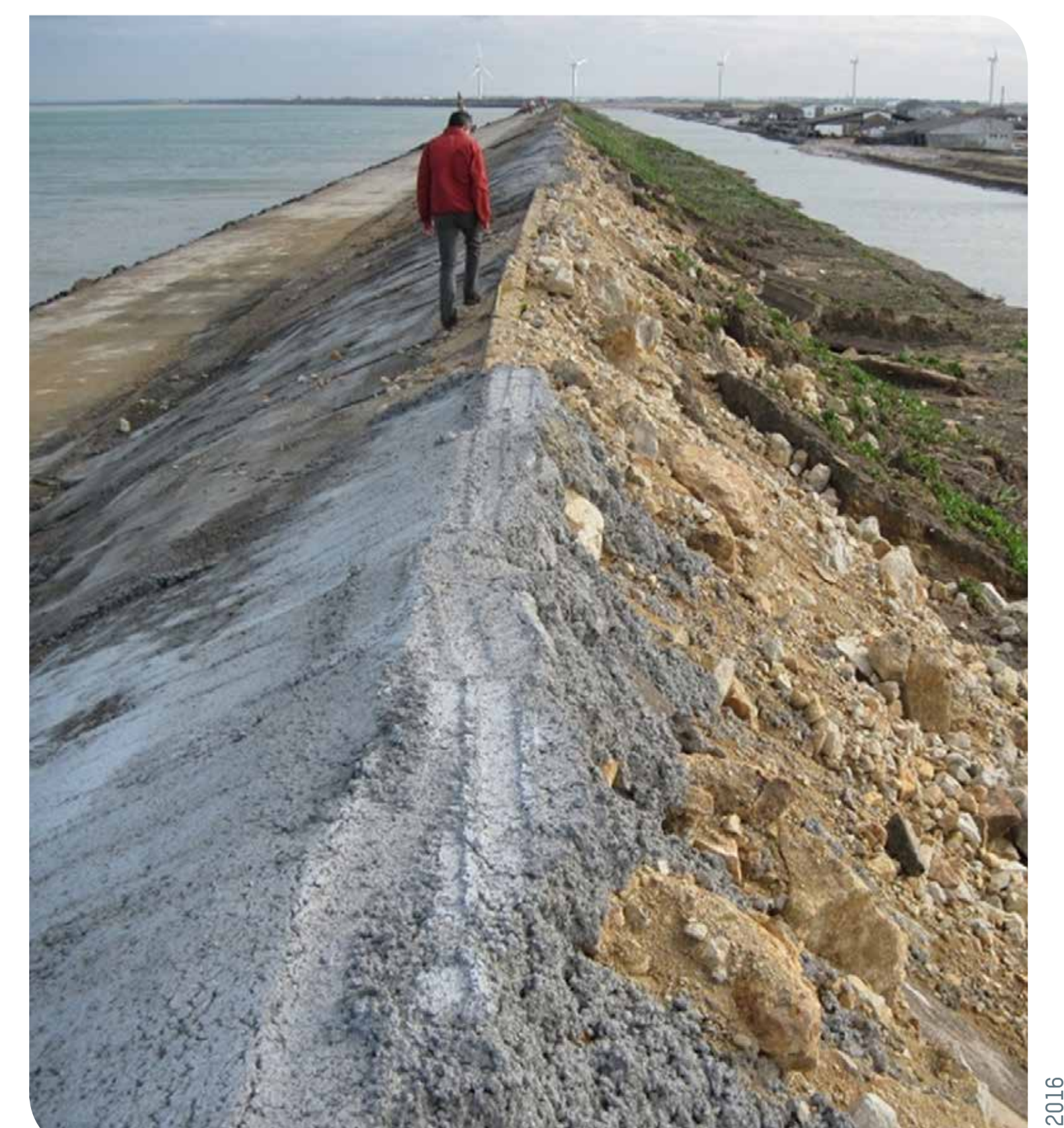
Désordres subis par une digue côtière surversée lors de la tempête Xynthia - Port du Bec (17) (© Cerema)
