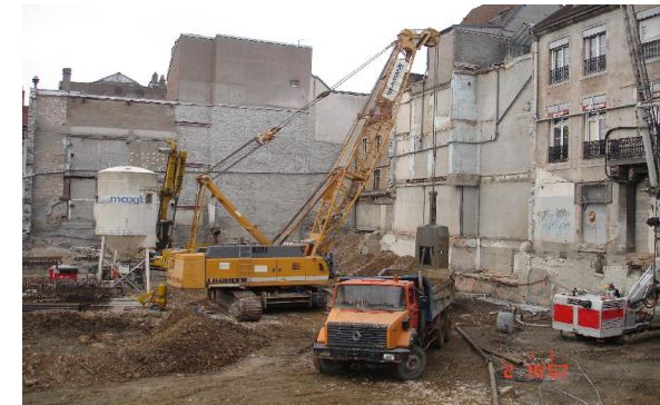
Travaux en cours - Février 2011
