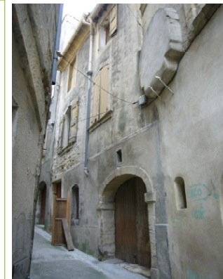
Quartier Mazères accueillant des hôtels particuliers du XVI et XVIIème siècle
