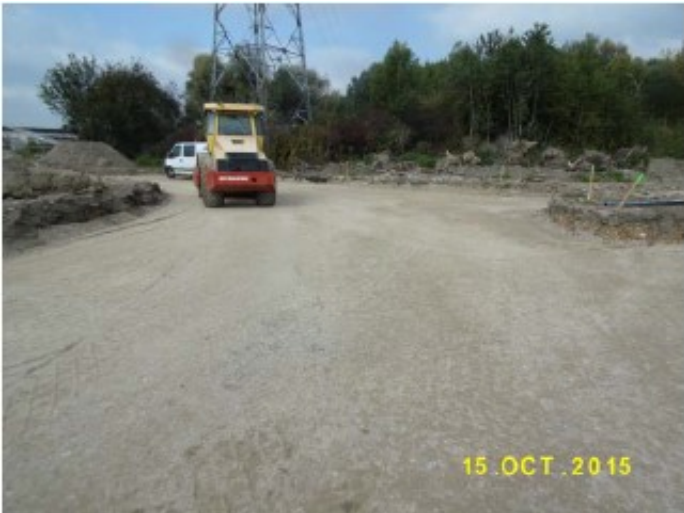
Compactage de la grave avant réalisation des EP au V3
