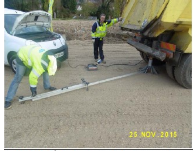
Réalisation des essais à la plaque sur la couche de forme
