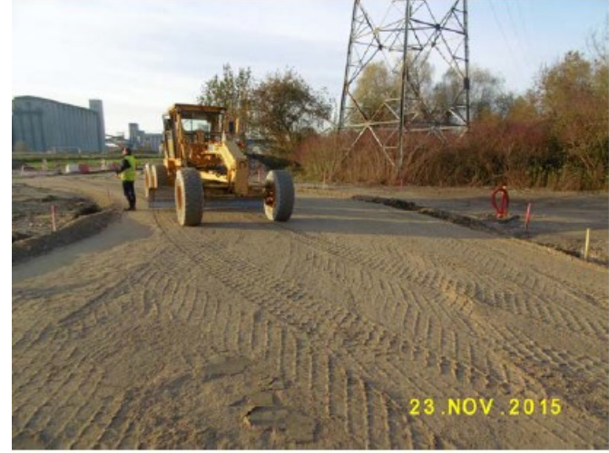
Mise en place de la grave naturelle réglée à la niveleuse
