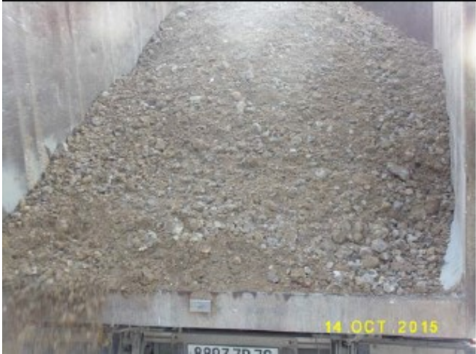
Grave livrée sur chantier par semi-remorque
