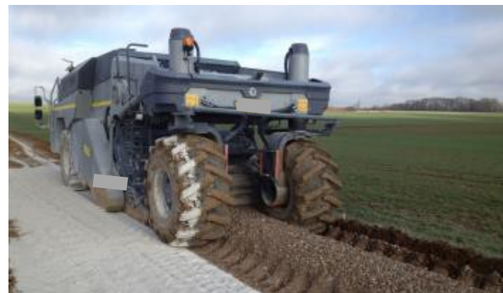
② malaxage en place au pulvérisateur -mélangeur
