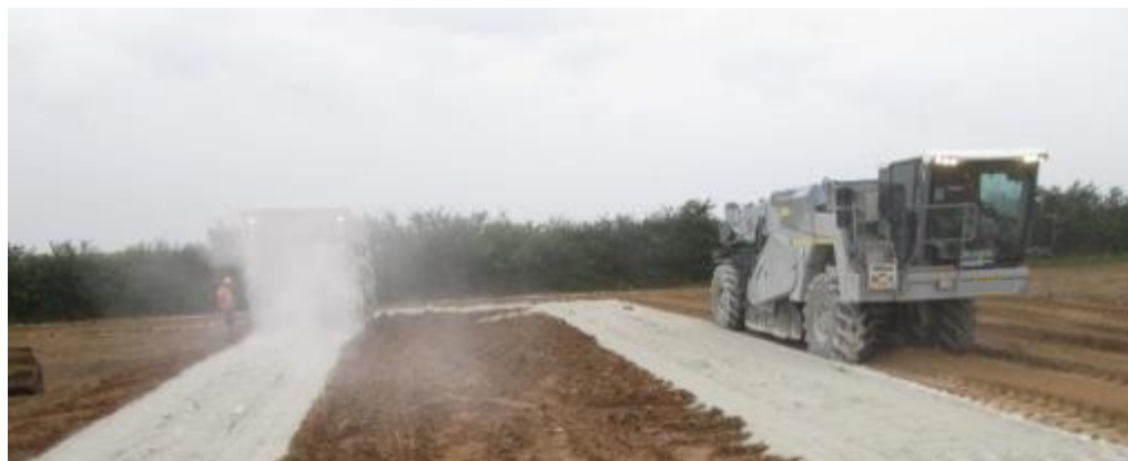
① répannage de la chaux
