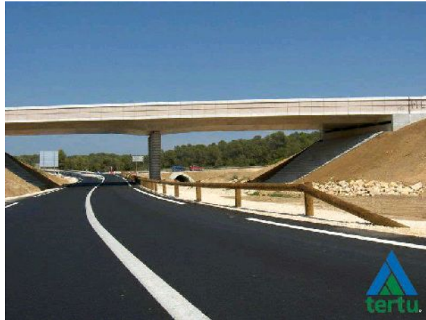
Déviation d'Assas : glissière bois, 90 km/h.
