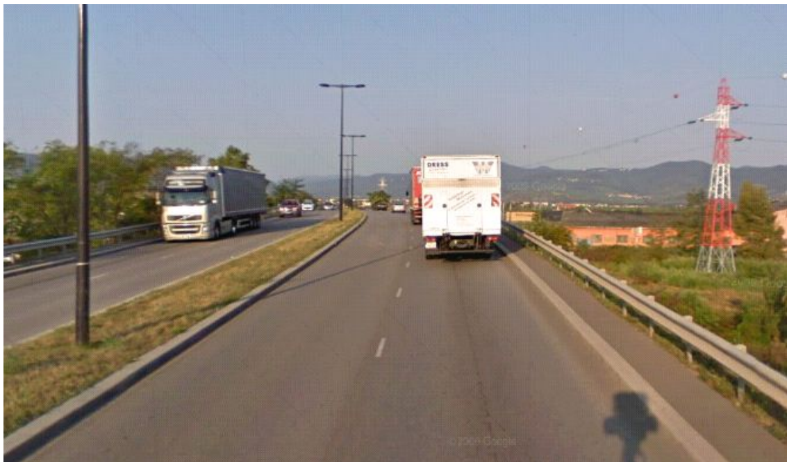
Colmar, Avenue de Lorraine: VRU U limitée à 70km/h, bordures basses en accotement, et glissière pour empêcher la chute des véhicules légers du remblai.
