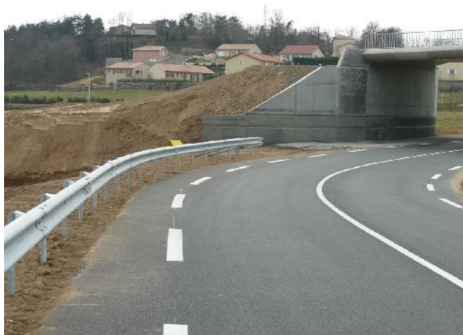
Glissière métallique en Ardèche, 70 km/h.
