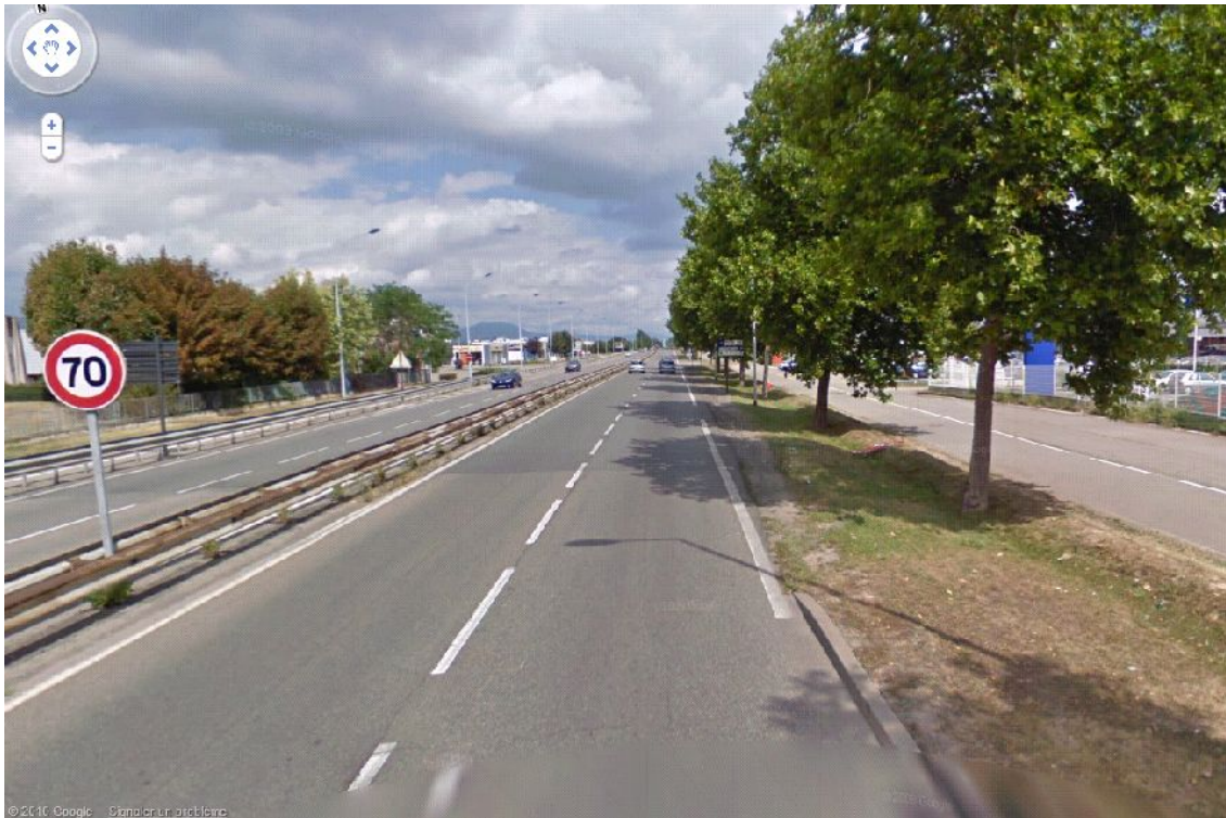
Colmar, route de Strasbourg : arbres entre 3,50 et 4 m du bord de chaussée, candélabres entre 2,50 et 3 m; pas d'accident corporel contre arbre depuis 10 ans, 30 000 véhicules par jour.
