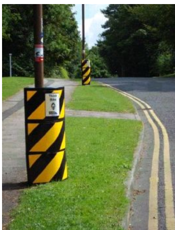
Support équipé d'une coque atténuant le choc
