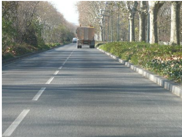
Bd L. Bonnevey, Villeurbanne: VRU U limitée à 70 km/h, simples bordures de trottoir, arbres entre 3 et 4 m.
