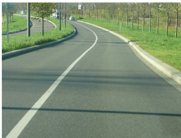
Bd urbain Est, St Priest, VRU U limitée à 70 km/h, simples bordures de trottoir, arbres à plus de 4 m à droite, obstacles à 1 m à gauche.
