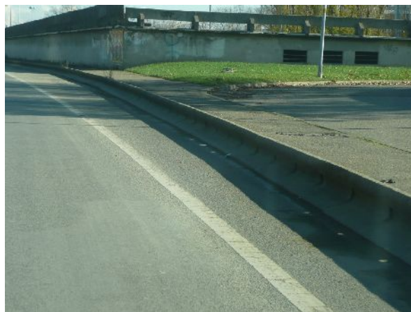
Av S. Allende, vaulx en Velin, VRU U limitée à 70 km/h, bordures de sécurité type GSS.
