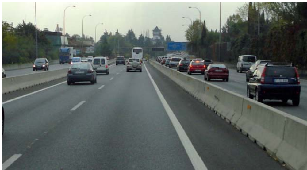
Tronçon de la voie ouvert aux bus et au covoiturage (Cetu)
