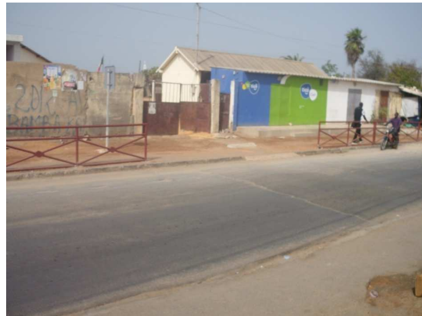
Pose de barrières de sécurité
