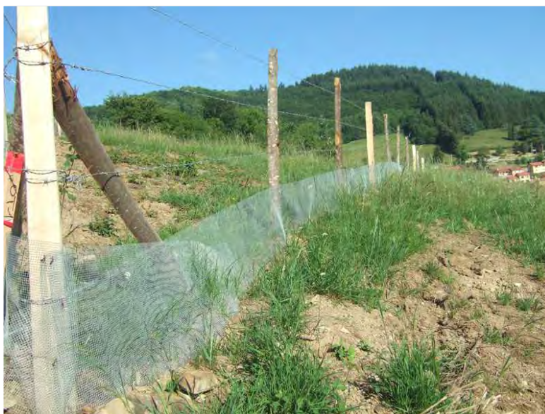
Illustration 10 : une mesure de réduction : filets à amphibiens (Source : Cerema)
