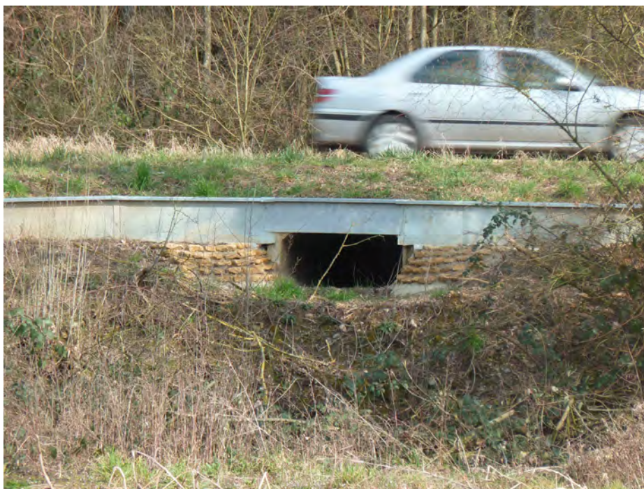
Illustration 9 : une mesure de réduction : passage inférieur (Source : Cerema)
