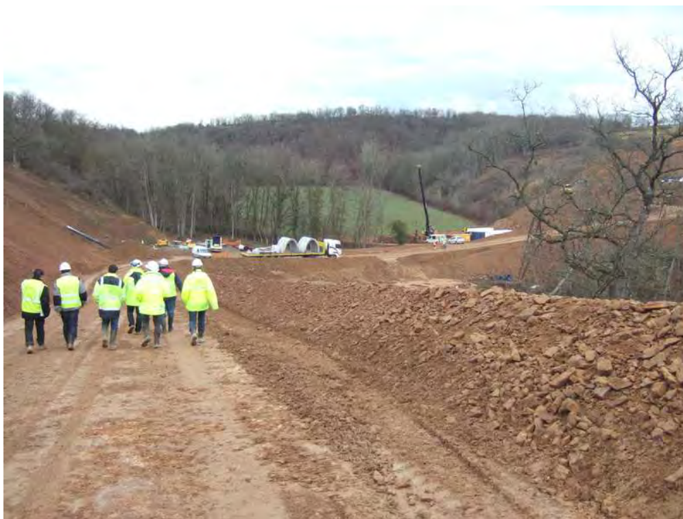
Illustration 8 : photo de chantier (Source : Cerema)
