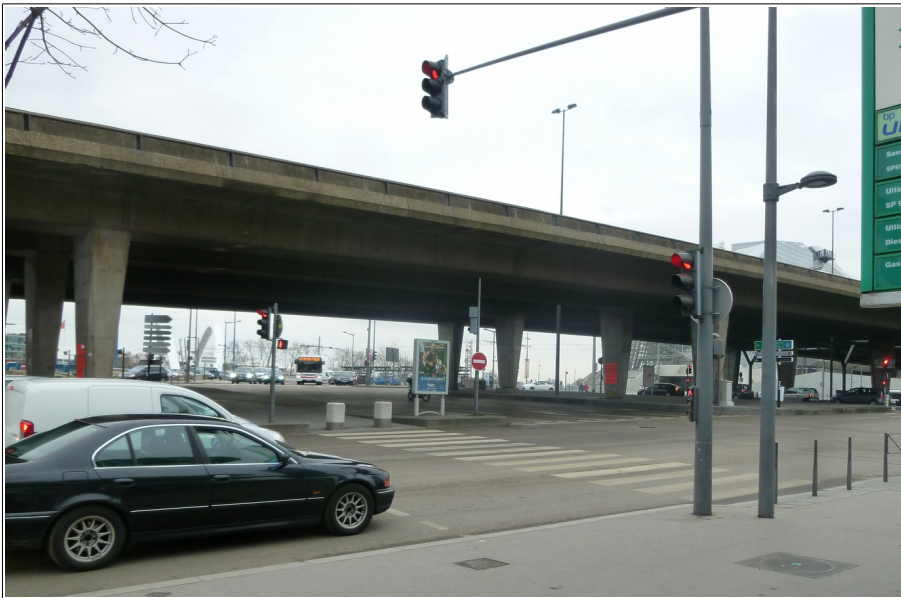
Illustration 24: Photo du carrefour Pasteur (source : Cerema)
