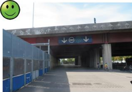
Illustration 25: Présence de signalétique vers la gare RER D via le Bd Wilson
