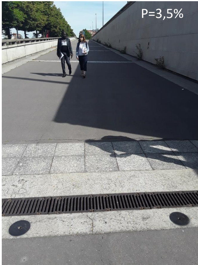
Rampe menant au parvis depuis l'avenue Wilson
