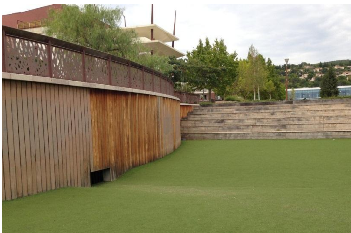
Figure 7 : Exemple d'aménagement de la ville de Draguignan : bassin de rétention avec gazon artificiel pouvant servir de lieu récréatif © Projet COPARI
