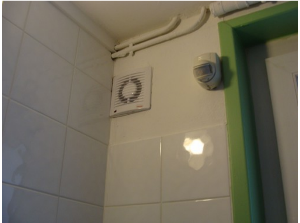
Illustration 7: Ventilation des sanitaires des femmes / handicapés
