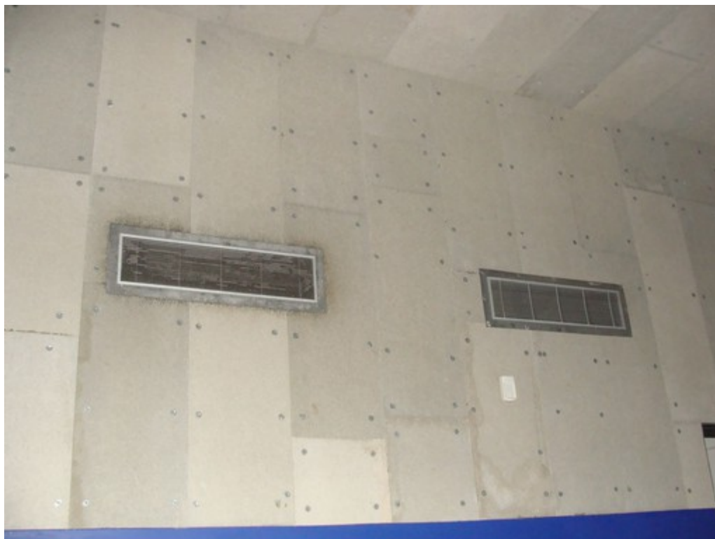
Illustration 87: Bouches de soufflage et d'extraction très proches dans la zone « Épilogue »
