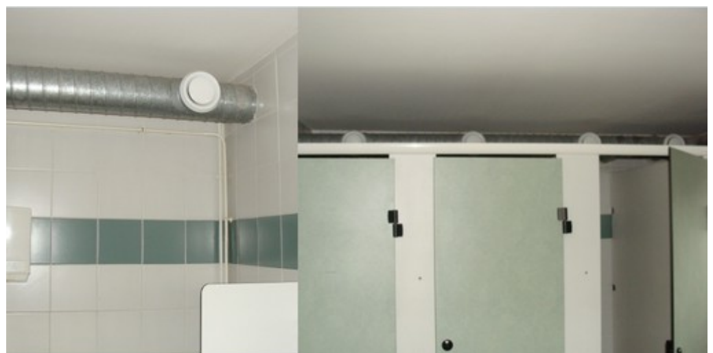
Illustration 126: Bouches d'extraction dans les sanitaires des hommes
