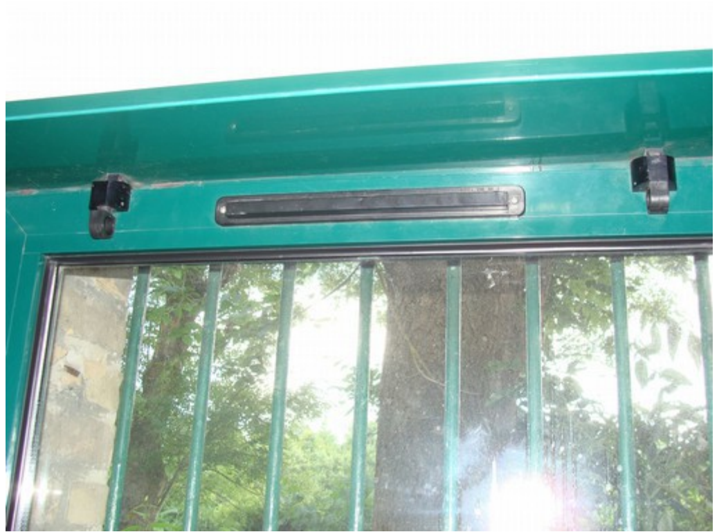
Illustration 127: Réglette d'entrée d'air dans les sanitaires des hommes
