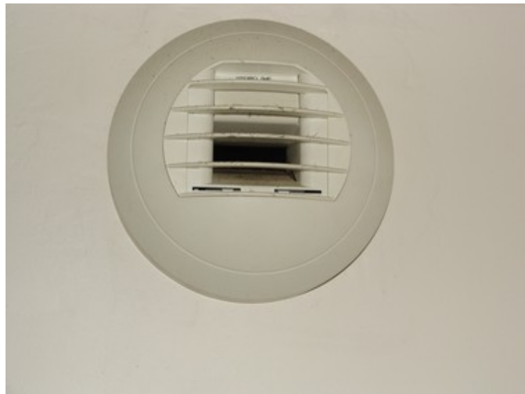
Illustration 78: Bouche d'extraction très légèrement sale des sanitaires de l'entresol
