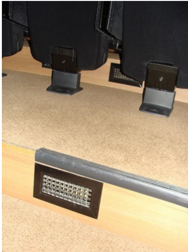
Illustration 90: Grilles d'extraction dans le planétarium
