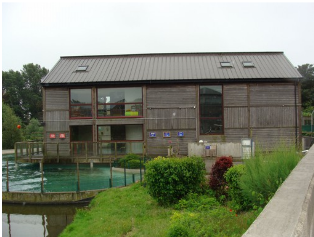
Illustration 36: Bâtiment portuaire B5
