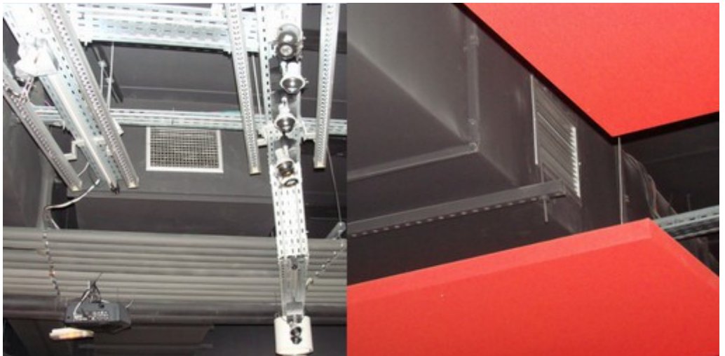
Illustration 85: Bouches (extraction/soufflage) dans les zones d'exposition permanente
