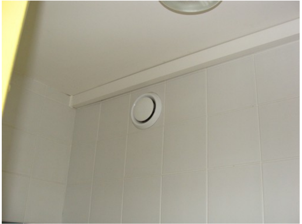
Illustration 128: Bouche d'extraction dans les sanitaires des femmes/handicapés
