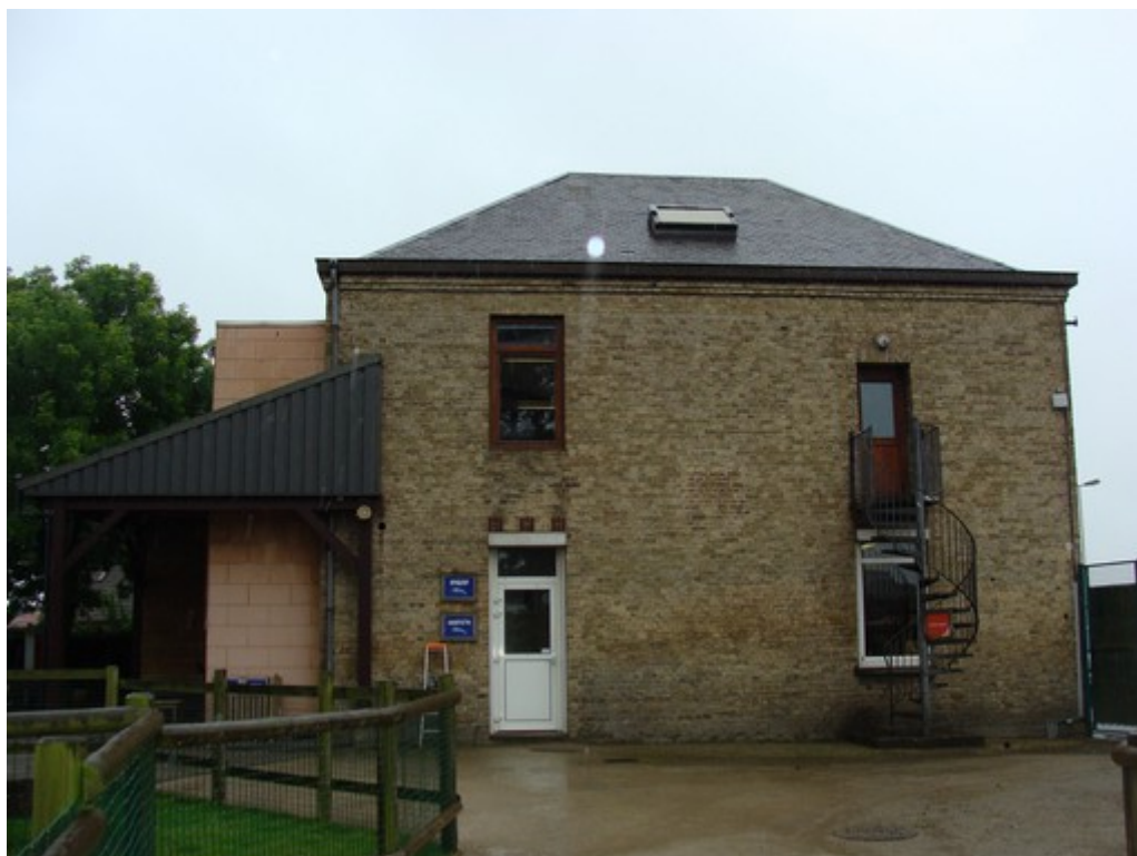
Illustration 39: Bâtiment administratif B7
