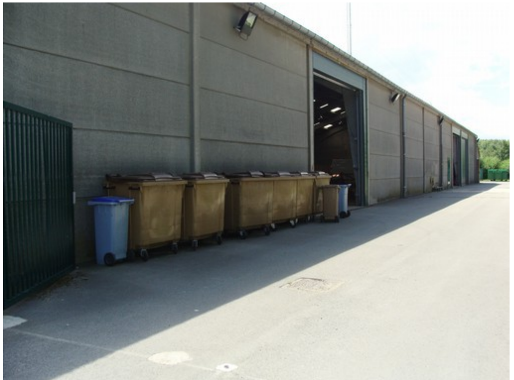
Illustration 124: Hangar de l'Atelier du Bois des Forts
