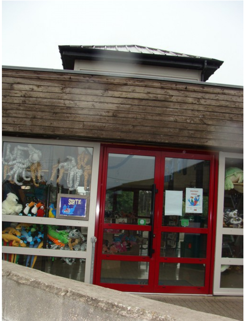
Illustration 33: Entrée du bâtiment B4 d'accueil
