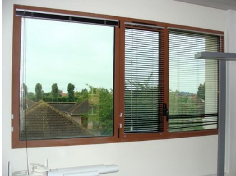
Illustration 77: Fenêtre d'un bureau avec entrée d'air
