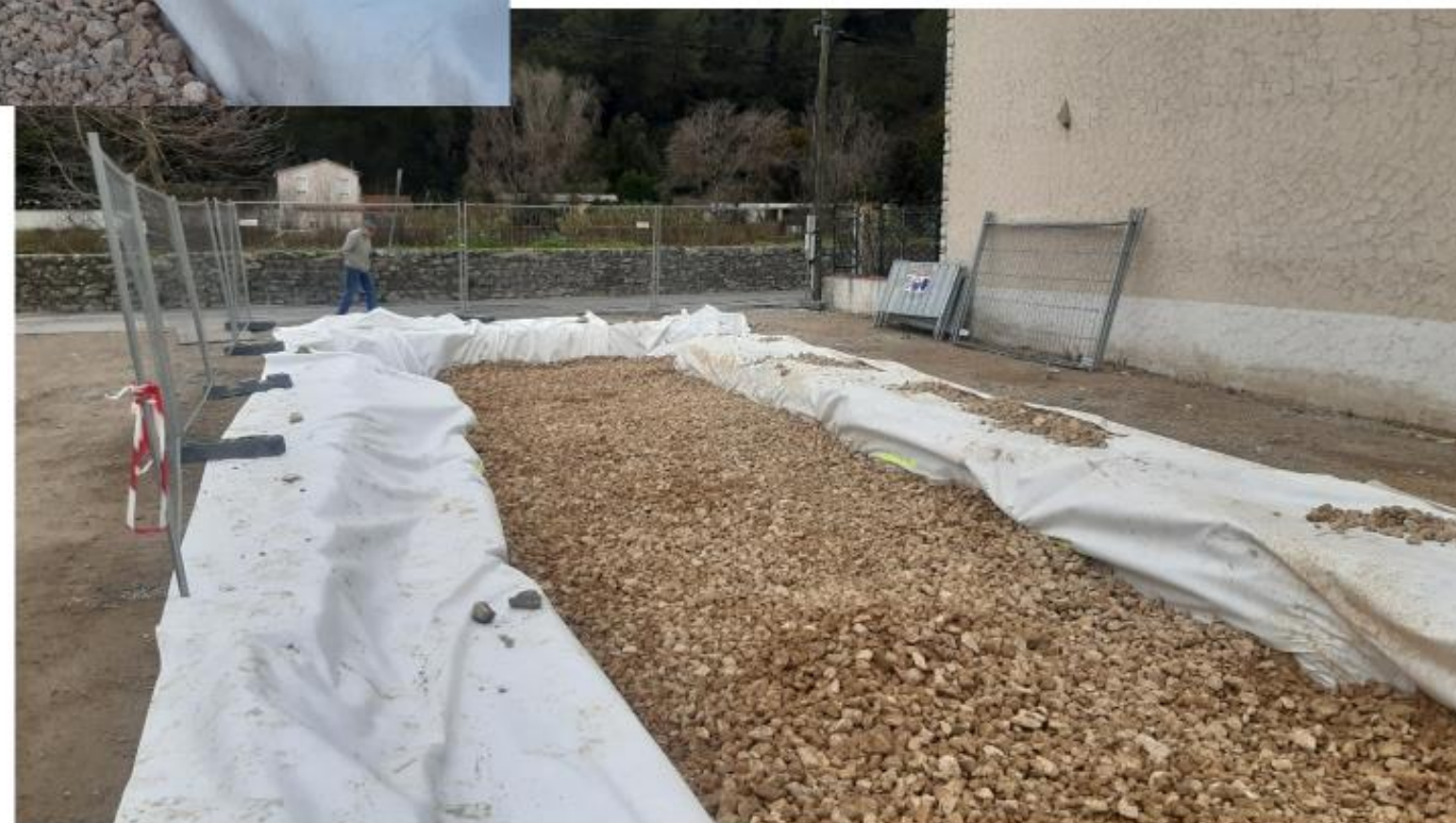
Mise en place de ballast sur 1 m d'épaisseur
