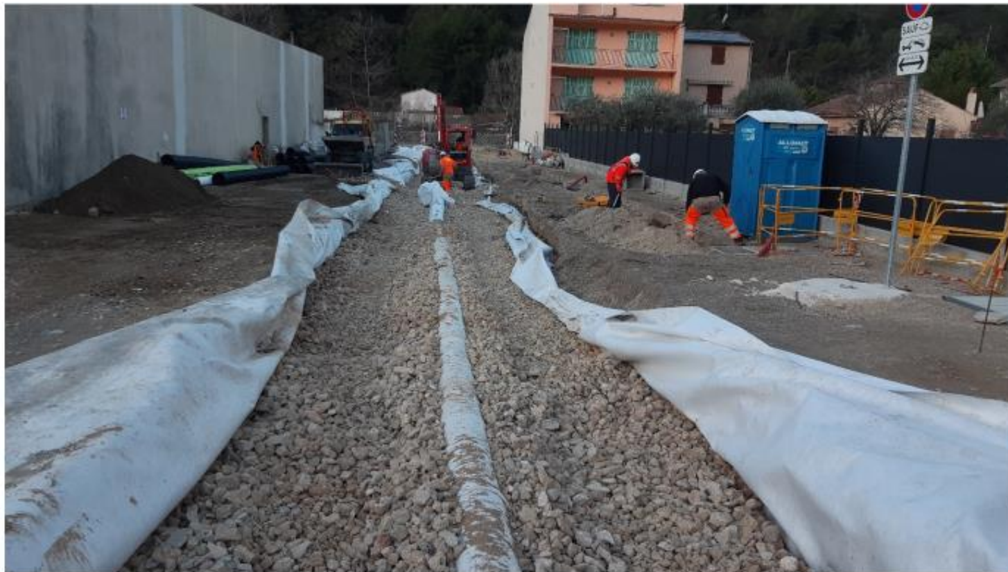
Mise en place d'un drain routier Ø300
