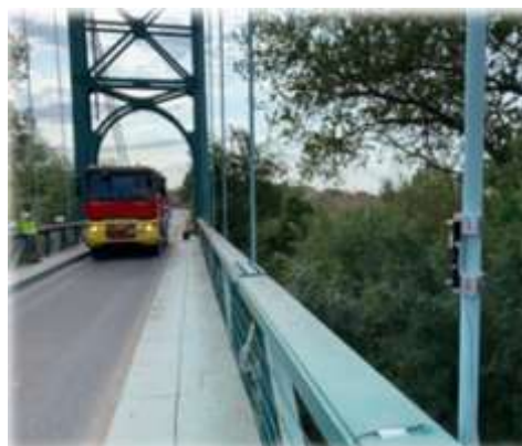
Figure 6 : Passage du convoi sur l'ouvrage instrumenté
