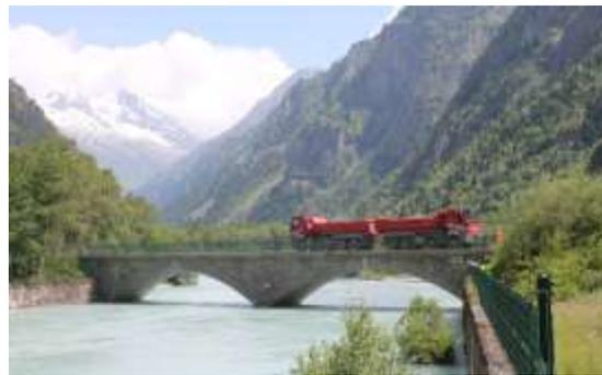
Figure 4 : Vue d'un ouvrage maçonnerie lors des essais de chargement ©Quadric
