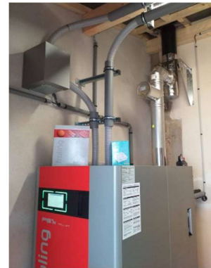
Figure 5 : Remplacement de la chaudière de la mairie de Bellefontaine
