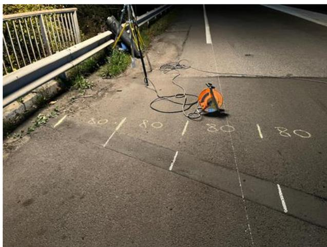
*Photo 3 : Marquage des profils longitudinaux pour le Géoradar*
