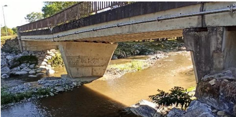
**Vue aval de l'ouvrage (et du sapement du pied de la pile ), en direction de l'amont du cours d'eau**
