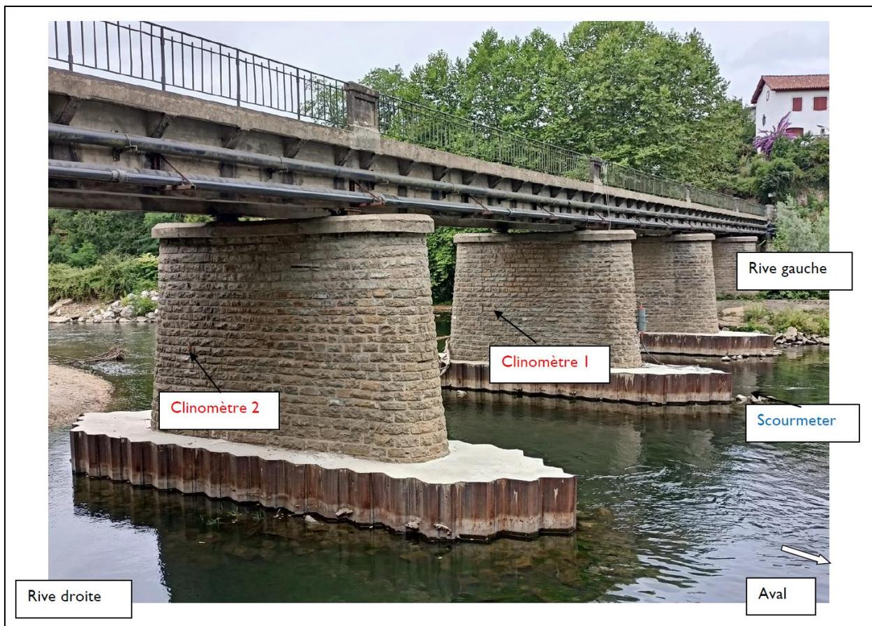
**Vue de l'instrumentation du pont (Scourmeter V2), Ustaritz**
