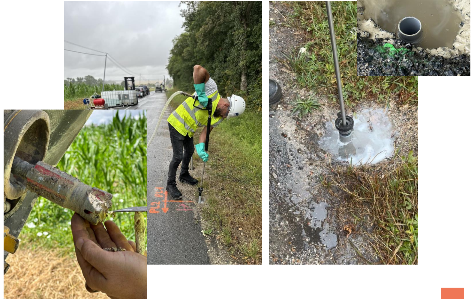
Stabilisation des sols argileux par bio-cimentation pour conforter la RD151 (CD45)
