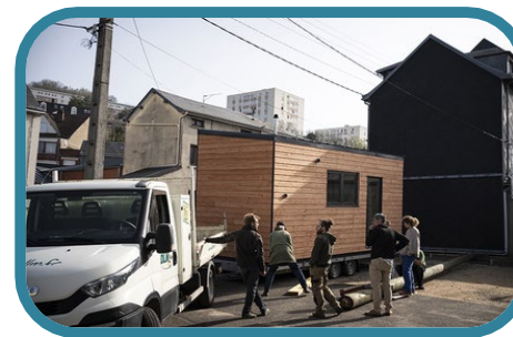
Installation du prototype sur un terrain
