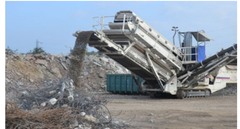
Fabrications de graves issues de la déconstruction
