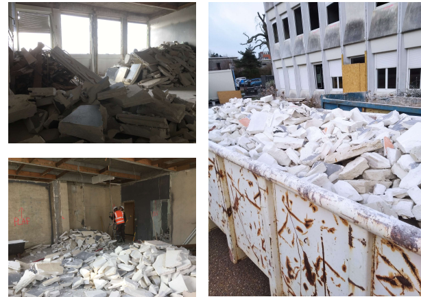
Tri et évacuation Plâtre - Dieppe
