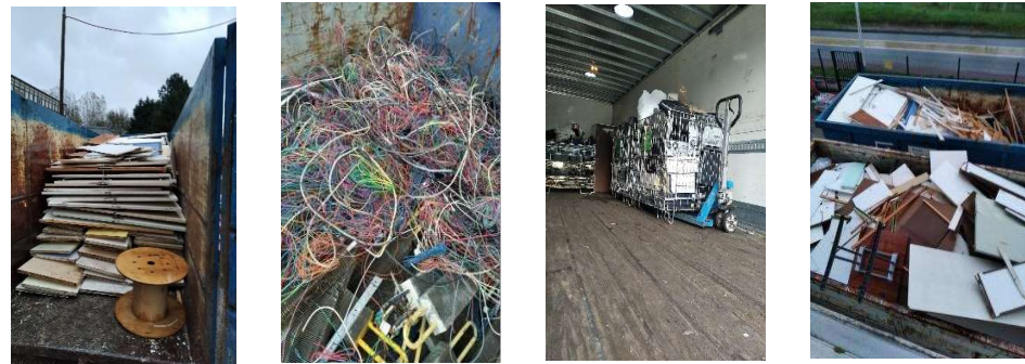
Optimisation de bennes et évacuation - Dieppe
