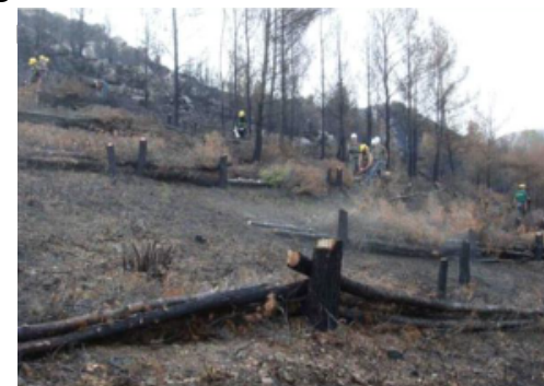
Exemple de fascine en bois
