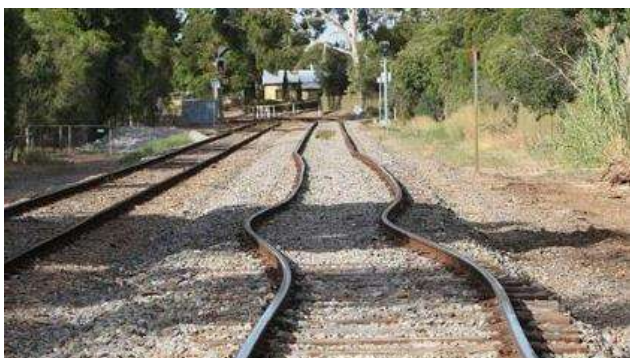
Stabilité transversale et longitudinale de la voie
