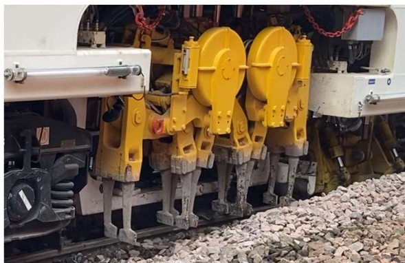
Reprise rapide de la géométrie de la voie
