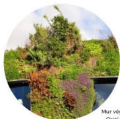
Mur végétal du Musée Quai Branly (Paris)
