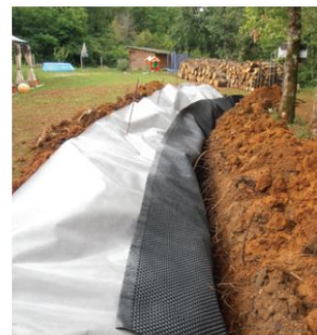
Voile polyester. La coupure capillaire est protégée par deux films plastiques alvéolés
