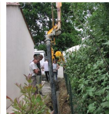
Écran en béton classique (tranchée de 30 cm coulée en béton pleine fouille)
