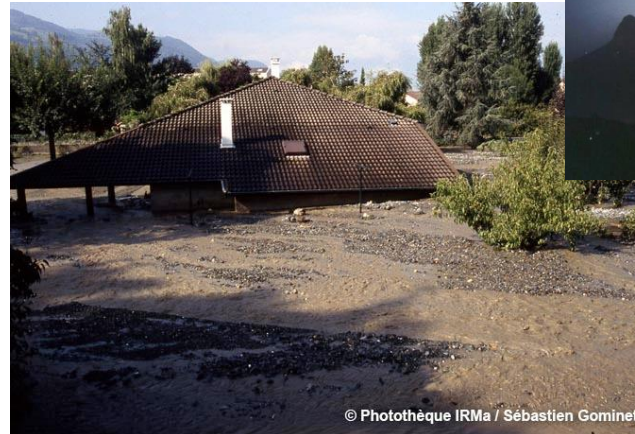
Crue torrentielle du Doménon, 2005
