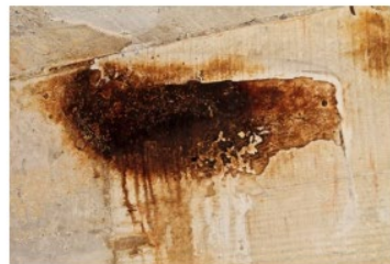
Marquage sur une paroi verticale à l'intérieur d'un pont « caisson » trahissant la présence de Grands murins © Yoann PEYRARD
