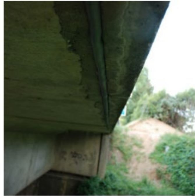
Cavité bouchée à l'aide de gaine d'isolation de tuyaux de chauffage © Sophie BAREILLE
