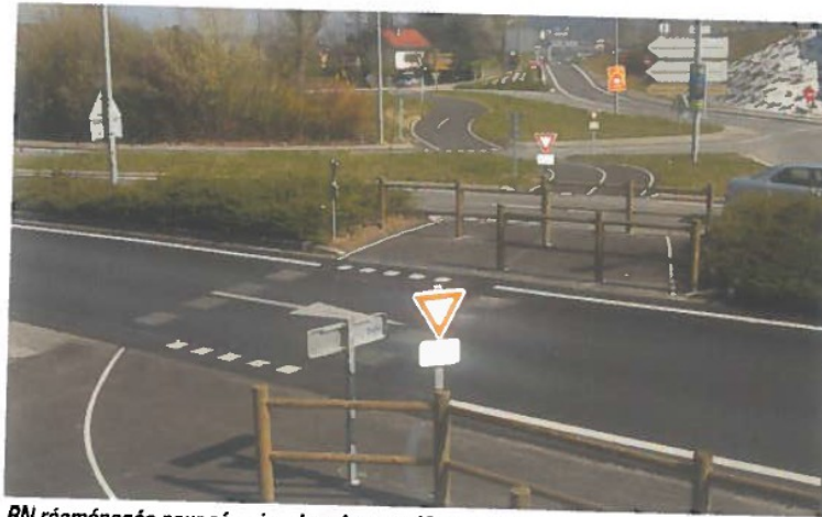
RN réaménagée pour sécuriser la voie verte (CETE Lyon)
