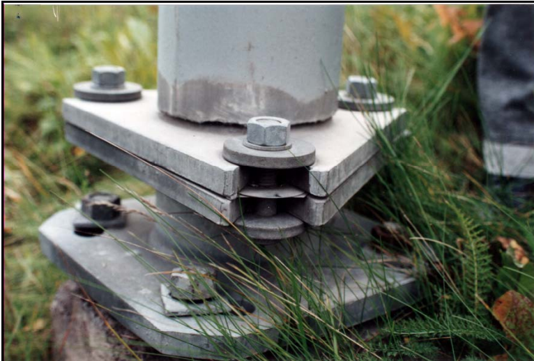
Illustration d'une embase glissante unidirectionnelle
