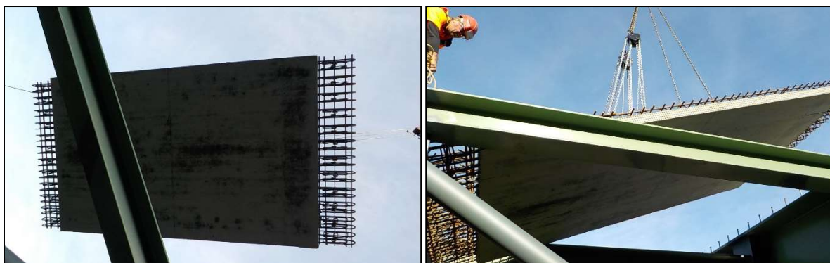
Figure 52 : Mise en place des prédalles du hourdis inférieur (©DIR Med)
