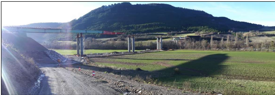
Figure 1 : Vue générale du viaduc du Lot en cours de construction
