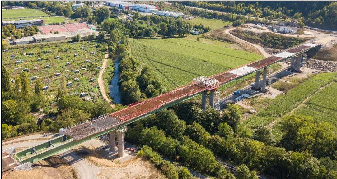
Figure 40 : Vue du tablier pendant le bétonnage de la dalle (©DIR Med)
