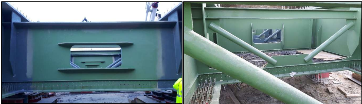
Figure 31 : Diaphragmes et cadres d'entretoisement intermédiaires
