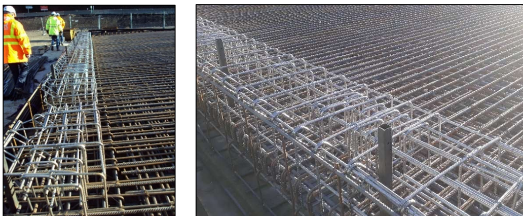
Figure 38 : Armatures inox dans les longrines supports des dispositifs de retenue
