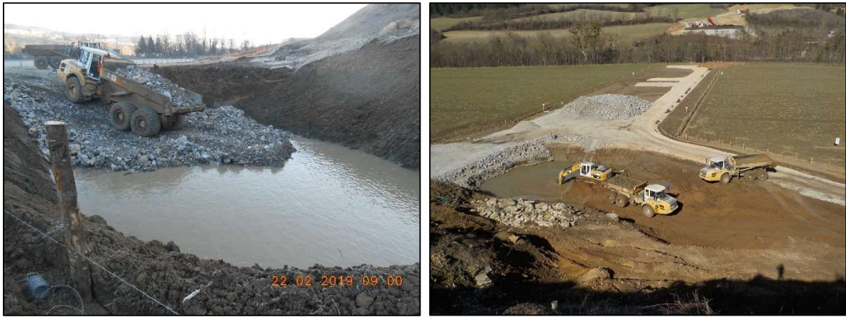
Figure 35 : Mise en œuvre de la bêche sur C0 (©DIR Med)
